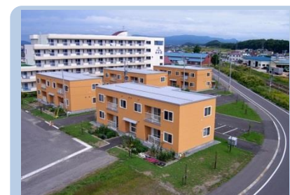
公営住宅駅前団地（平成22年）
