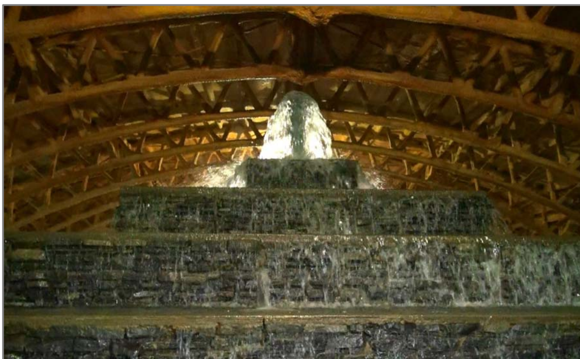
図 2-4. エアレーション施設
