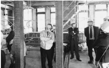
郷土資料館工事現場視察
